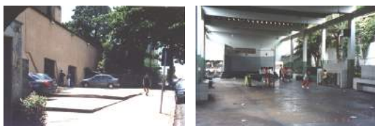
Fachada lateral e pátio interno da E.E. DR. JOÃO RODRIGUES GUIÃO
